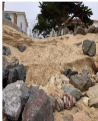
Dépression du 15 novembre : travail de sape sur l'enrochement entre 47 et 49 pourtant renforcé par du béton. L'accès 48 est impraticable.
