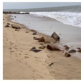
Dépression du 15 novembre : travail de sape sur l'enrochement entre 47 et 49 pourtant renforcé par du béton. L'accès 48 est impraticable.
