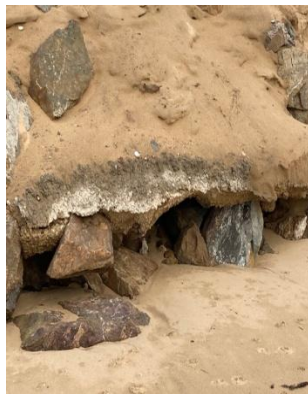
Dépression du 15 novembre : travail de sape sur l'enrochement entre 47 et 49 pourtant renforcé par du béton. L'accès 48 est impraticable.
