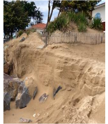
Dépression du 15 novembre : travail de sape sur l'enrochement entre 47 et 49 pourtant renforcé par du béton. L'accès 48 est impraticable.
