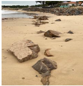
Dépression du 15 novembre : travail de sape sur l'enrochement entre 47 et 49 pourtant renforcé par du béton. L'accès 48 est impraticable.
